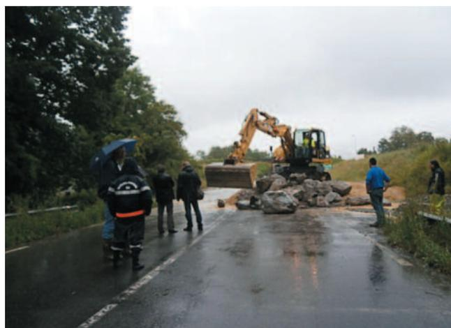
Construction d'une digue sur la RD 937 pour protéger le moulin de Caumont en détournant l'écoulement du Gave
