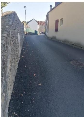
Les travaux de réfection de la rue du Presbytère se sont déroulés courant septembre 2023. Ils consistaient en un reprofilage de la chaussée, une pose de bordures ainsi que la création d'un puisard pour récupération des eaux pluviales.
